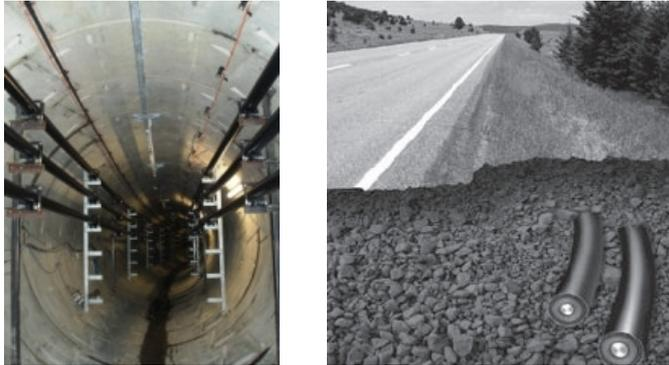
links: Hochspannungskabel in einem Kabelkanal. Risiko einer Beschädigung durch geologische Sondierungen kann praktisch ausgeschlossen werden.
